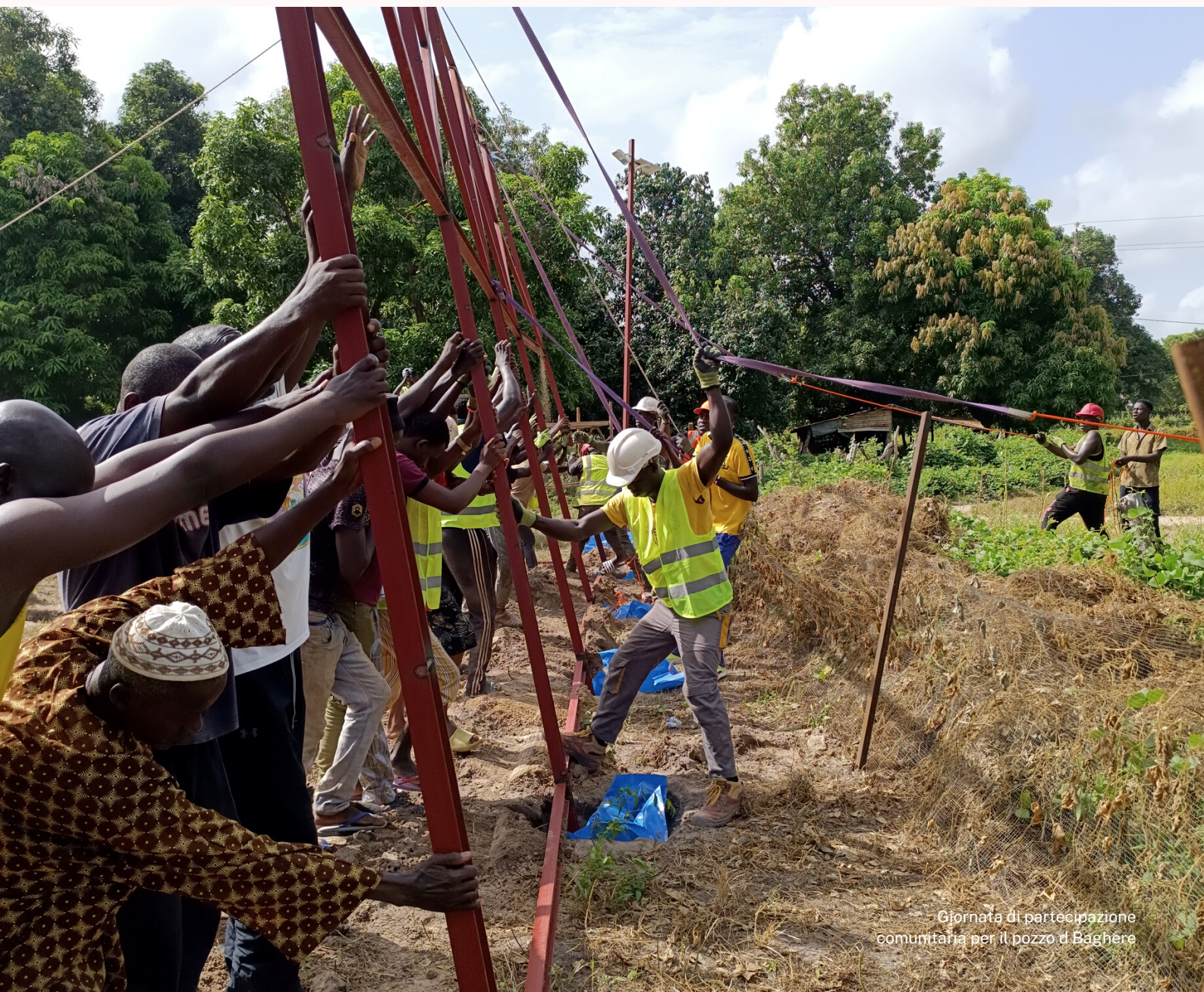
Scavo delle fondazioni del Centro Balouo salol
